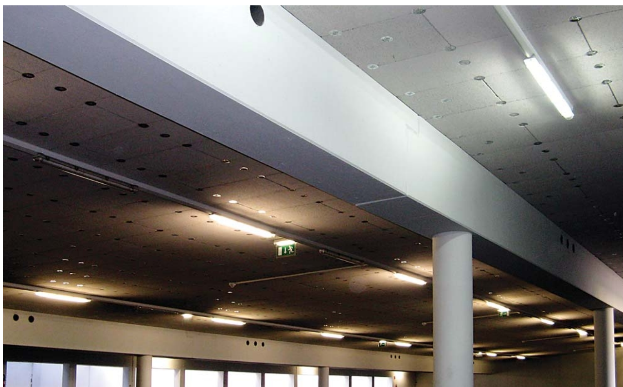
3i - stropní izolační desky dodatečná montáž hmoždinami
